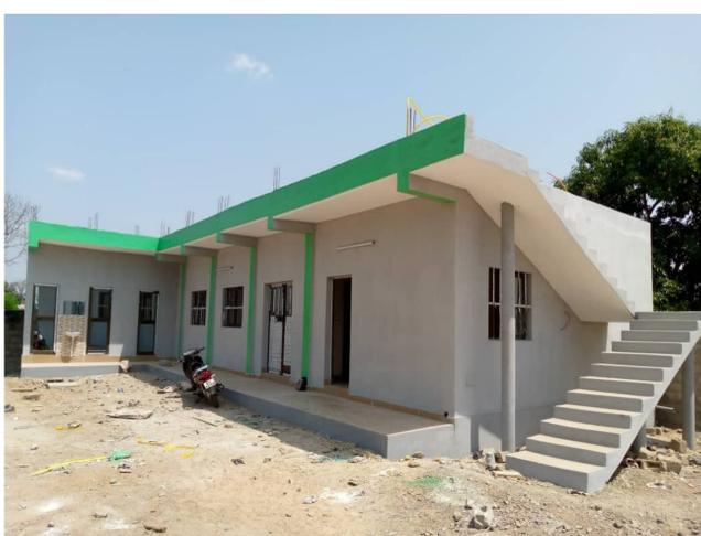
An der Seite ist eine Treppe zu sehen, die auf das Dach führt. Zum einen war diese für die Installation der Solaranlage erforderlich und zum anderen wollen wir uns die Möglichkeit offen halten, das Gebäude um eine Etage zu erweitern. Die Terrasse bzw. der Eingangsbereich ist leicht erhöht und entspricht der typischen Bauweise in Togo: Überschwemmungen werden durch den Absatz vorgebeugt.
